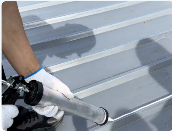
2. 在屋顶表面涂抹粘合剂。
